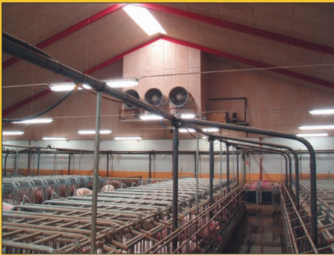
Her ses skakten fra løbeafdelingen. Den tager ikke plads på gulvet, og den er billig at etablere.
